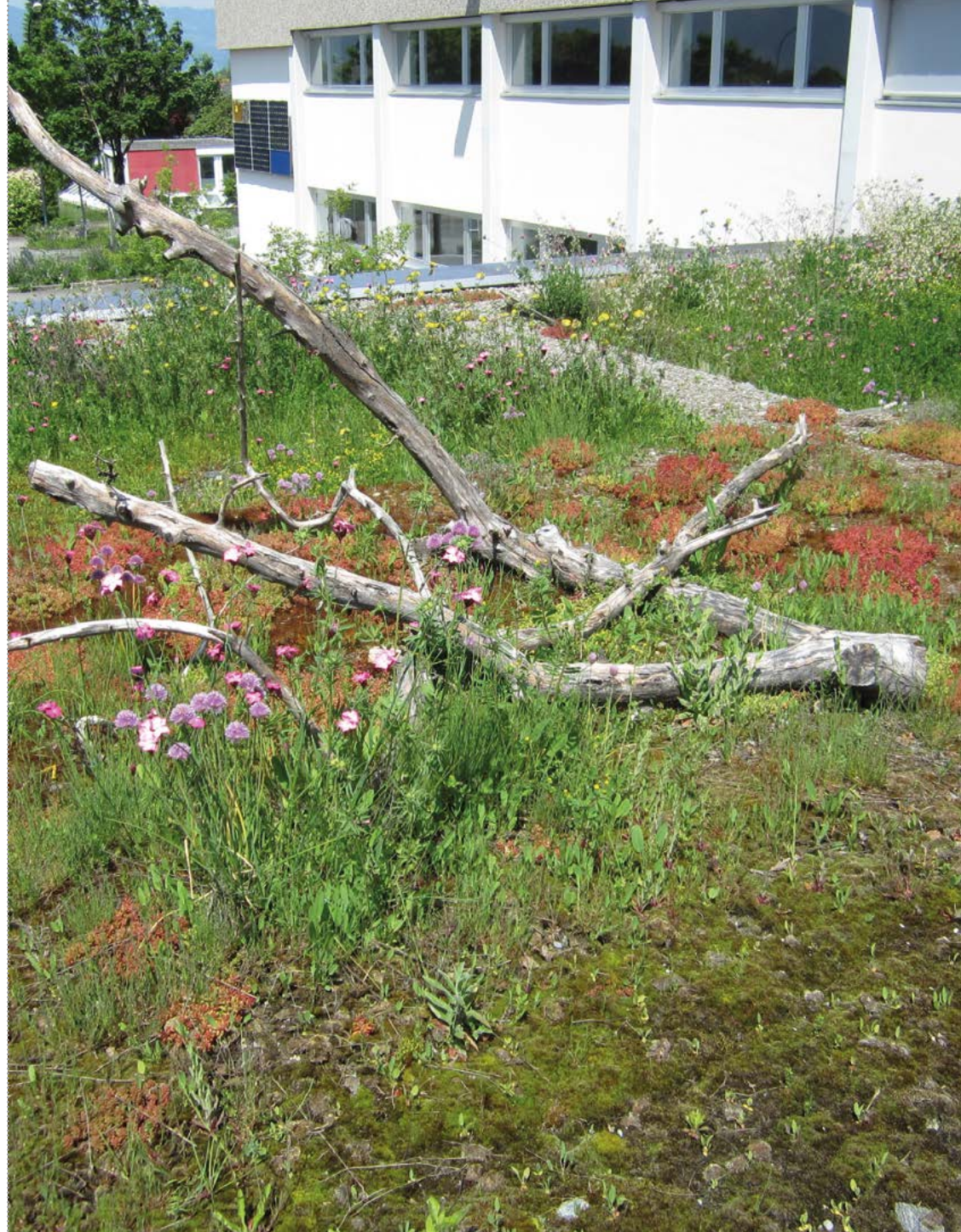
Begrünte extensive Dachfläche
